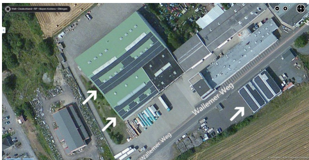
Photovoltaikanlage auf dem Dach der betreffenden Firma
